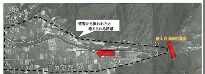
砂防堰堤下流状況写真（竣工し、その後河川改修）
