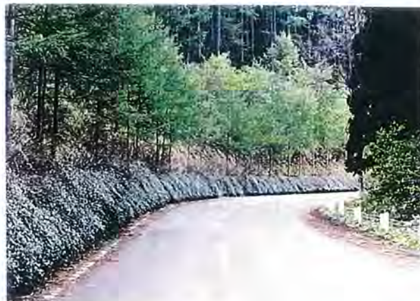
林道等の整備は山を削る行為を伴う。発生した法面に積極的な緑化を行い、自然豊かな印象の道路景観を創出している。（県民の森地内）
