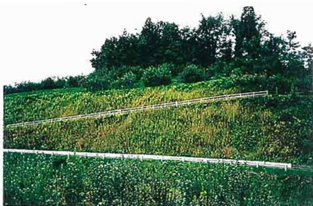
法面緑化と法肩の木本類の植栽により周辺の自然な景観と馴染ませている。しかし、道路に設置された白色のガードレールが緑化された法面から浮き立ってしまっている。
