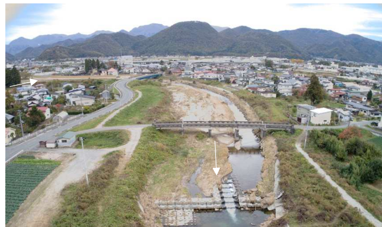
着工前 (青柳橋)
