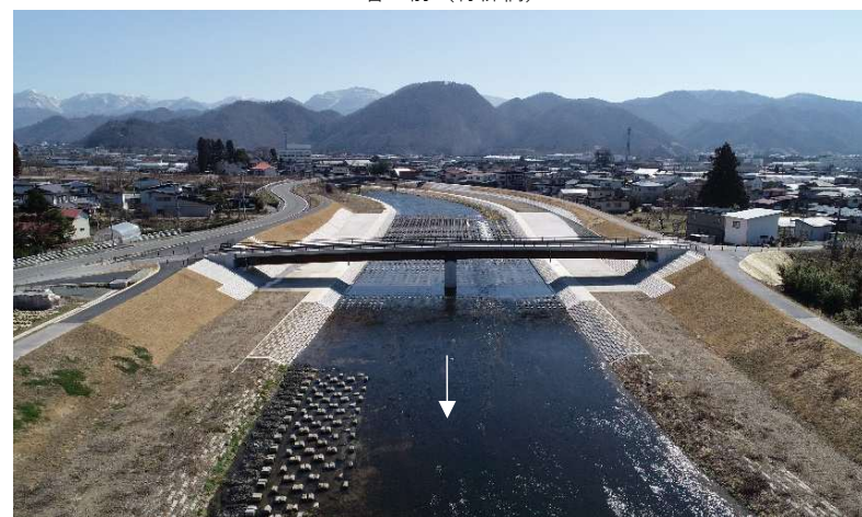
整備状況 (青柳橋)
