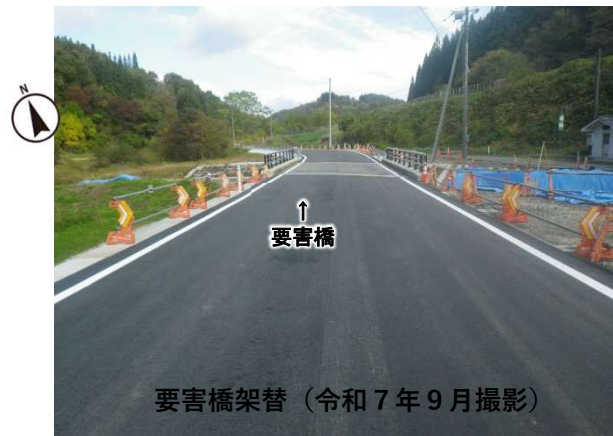
河川整備状況 (令和7年9月撮影)
