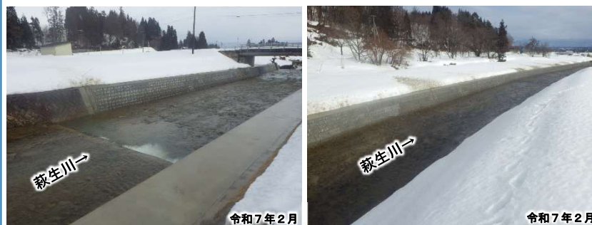
完成区間の状況
