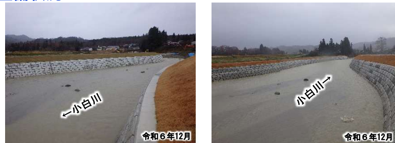
完成区間の状況
