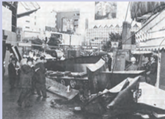
台風で落下した時の様子
