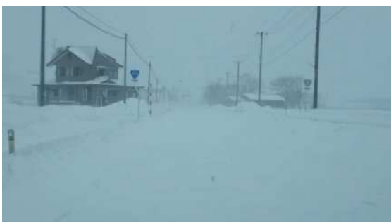
（整備前：地吹雪発生状況）
