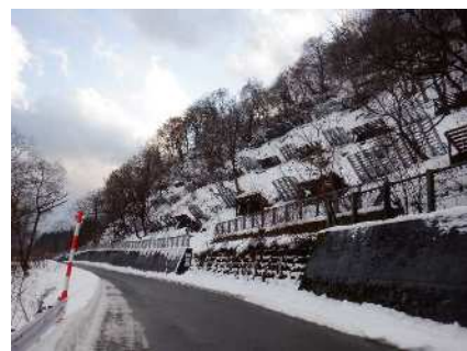
（整備後：雪崩予防柵設置完了）
