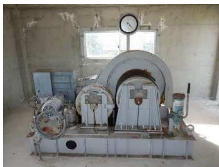
機械設備の補修
