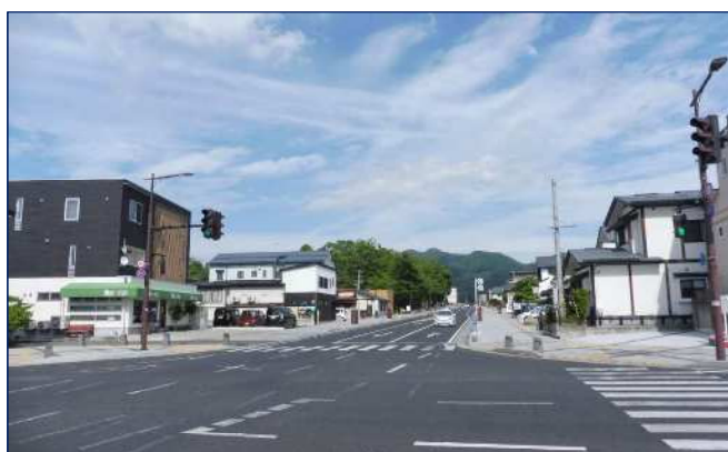
R4事業完了 四日町山家町線(山形市)
