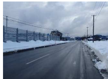
（整備後：防雪柵設置完了）
