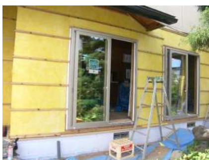
【寒さ対策・断熱化の例】 二重サッシの設置
