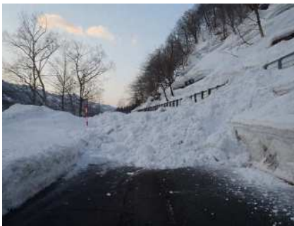
（整備前：雪崩発生状況）
