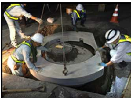
管路施設の耐震化 (マンホール浮き上がり防止)
