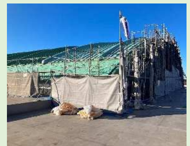
屋根改修(工事中 R6完了予定)
