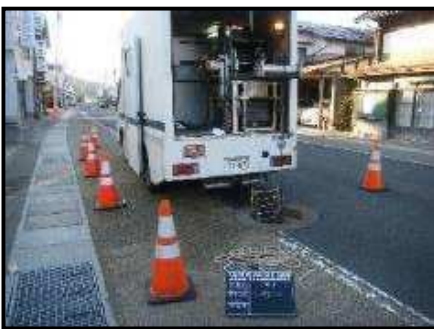
管渠点検調査 (テレビカメラ調査)
