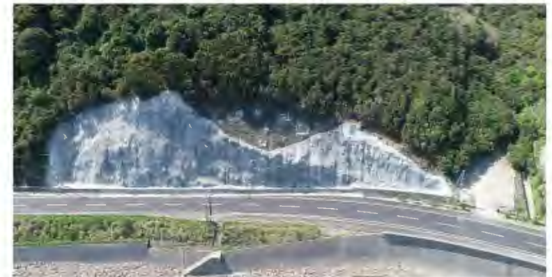
法面吹付工、落石防止網工
