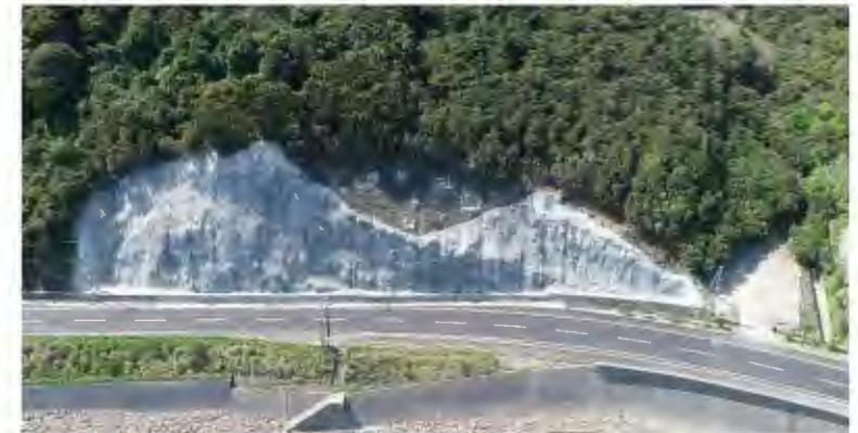
法面吹付工、落石防止網工
