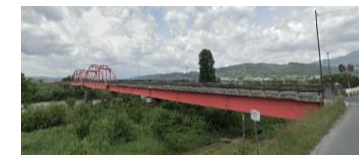
▲(主)寒河江村山線(河北町) 河北橋補修・架替(調査)
