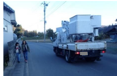
▲(主)大江西川線(大江町顔好) 通学路の歩道整備
