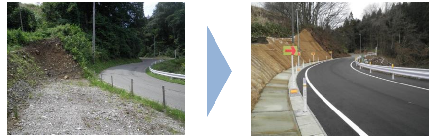
▲地域の実情に応じた道路改良の事例 (主)山形永野線(山形市土坂)の部分的な拡幅
