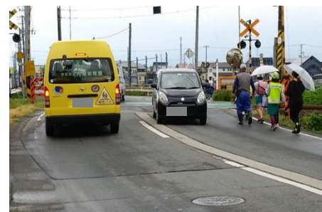
▲(一)泉田新庄線(新庄市太田踏切) 通学路の歩道整備(踏切拡幅)
