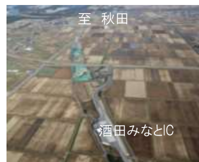
▲日本海沿岸東北自動車道 酒田みなとIC付近
