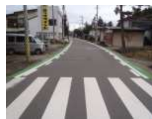
▲路肩カラーリングによる歩行空間確保 (一)万世窪田線 (米沢市川井)
