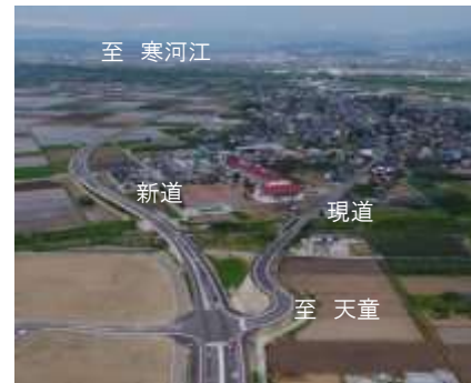
▲整備事例 (主)天童寒河江線(蔵増バイパス)
