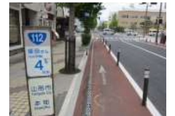
▲路肩幅のカラーリング、ポラードの設置による自転車専用通行帯の分離(国道112号 山形市本町)
