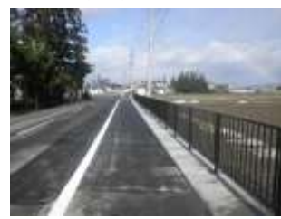
▲幅広路肩による歩行空間の創出 (国)287号 (川西町上小松)
