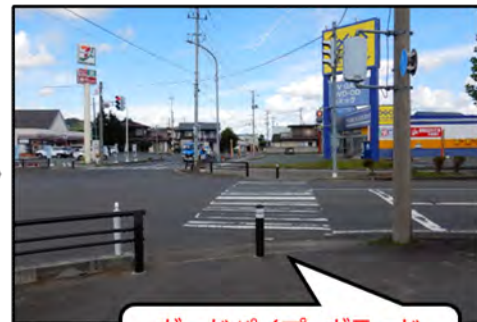
ガードパイプ、ボラード (車止め)を四隅に設置
