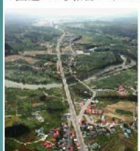
▼国道287号和合バイパス
