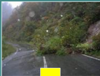
法面崩壊防止対策
