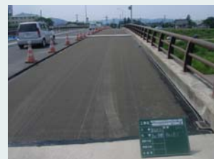
橋面防水工の施工
