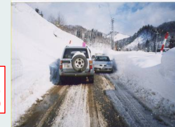
▲すれ違いに支障を来している箇所
