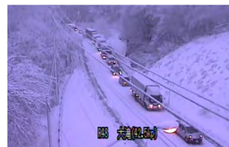
▲国道48号における冬期スタック発生状況 (東根市 H28.1)
