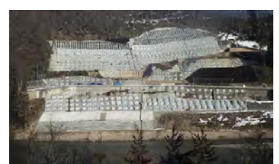
▲国道287号の地すべり対策 (白鷹町 H28.3)
