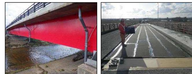
▲鋼橋主桁の塗装
