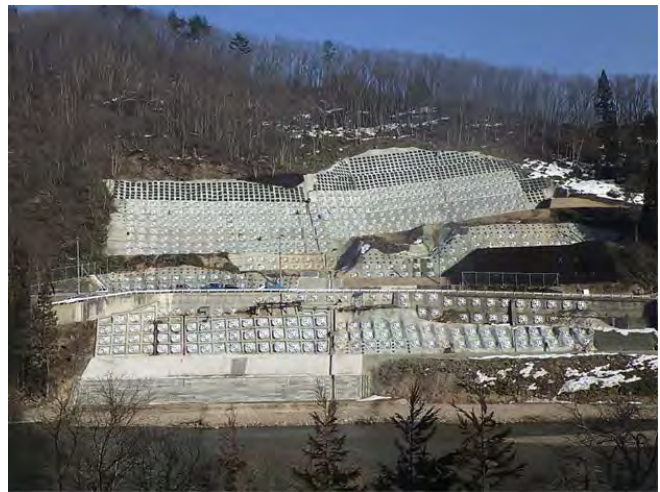
▲国道 287 号の地すべり対策状況 (白鷹町 H28.3 撮影)
