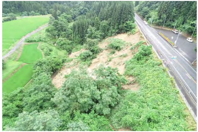
▲国道 348 号の法面崩壊 (白鷹町 R2.7)
