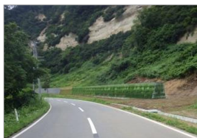
▲ (国) 458 号 (大蔵村南山) 落石防護擁壁
