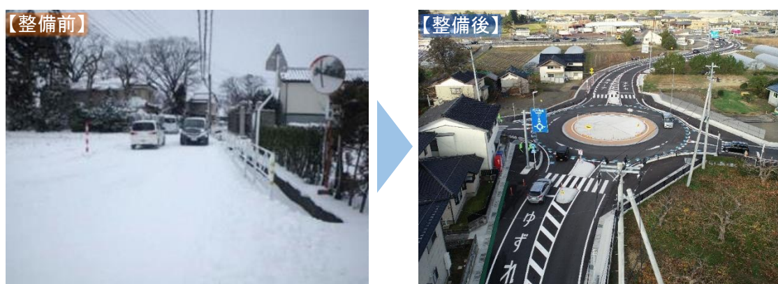
図 3-13 地域の実情に応じた道路改良の事例(交差点改良:ラウンドアバウトの整備) (一)浜中余目線(酒田市広野)
