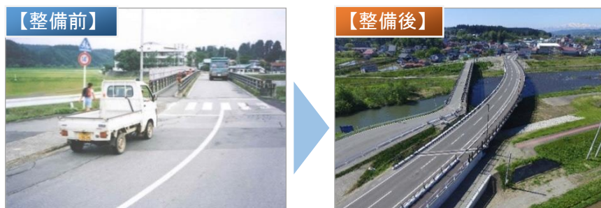
図 37 (主) 真室川鮭川線 安久土橋(真室川町)の橋梁架替事例
