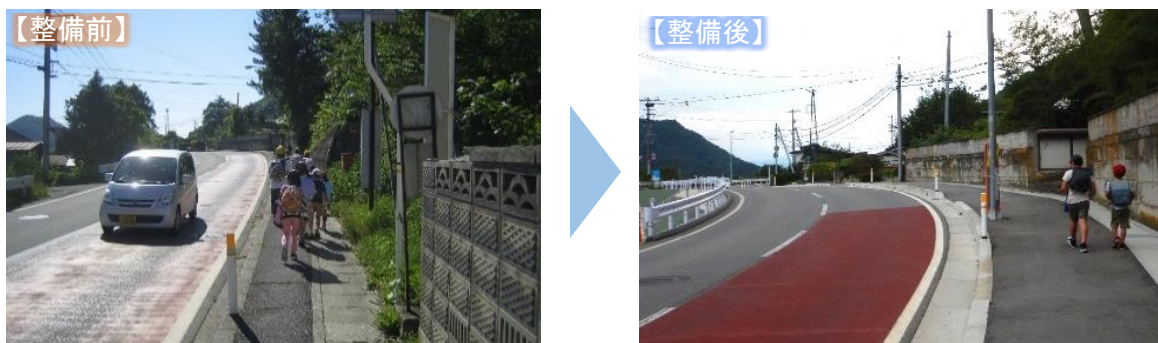
図 3-9 歩道整備の事例 (主)山形山寺線(山形市大字山寺)
