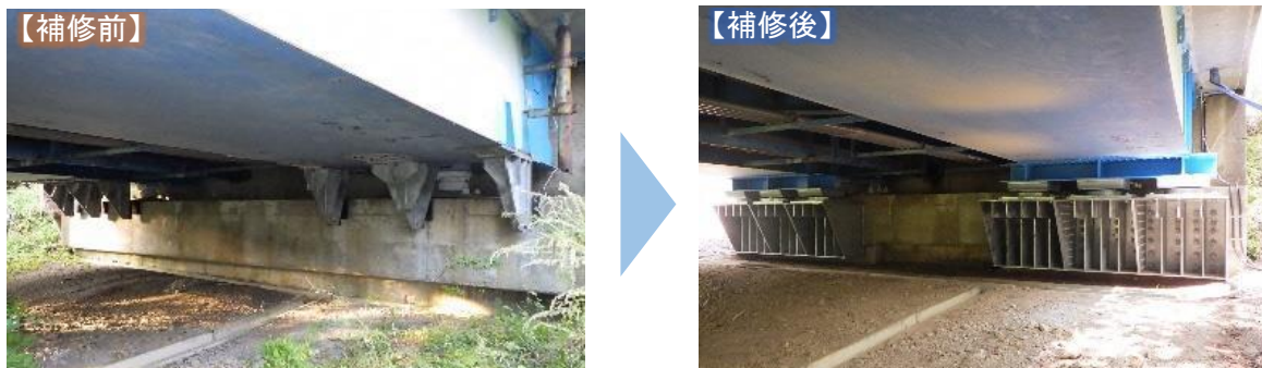
図 3-7 橋梁耐震補強の事例 国道 121 号(米沢市) 脇之沢橋
