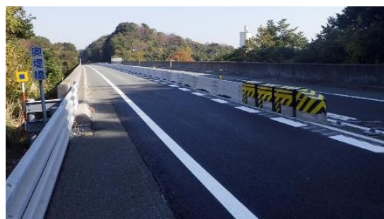
図 4-8 高規格道路の交通安全対策 センターブロック※の設置事例 (E2 山陽道 宇部下関線 奥堤橋)
