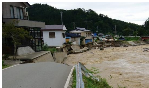
図 3-21 (一)片倉塩線 道路崩落(令和 2 年度)
