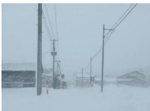
▲(一)万世窪田線(米沢市川井～上新田) 防雪柵
