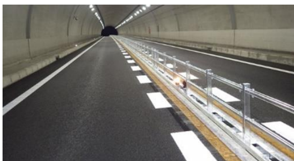
図 4-7 高規格道路の交通安全対策 センターパイプ※の設置事例 (C3 東海環状道 栢洞トンネル)
