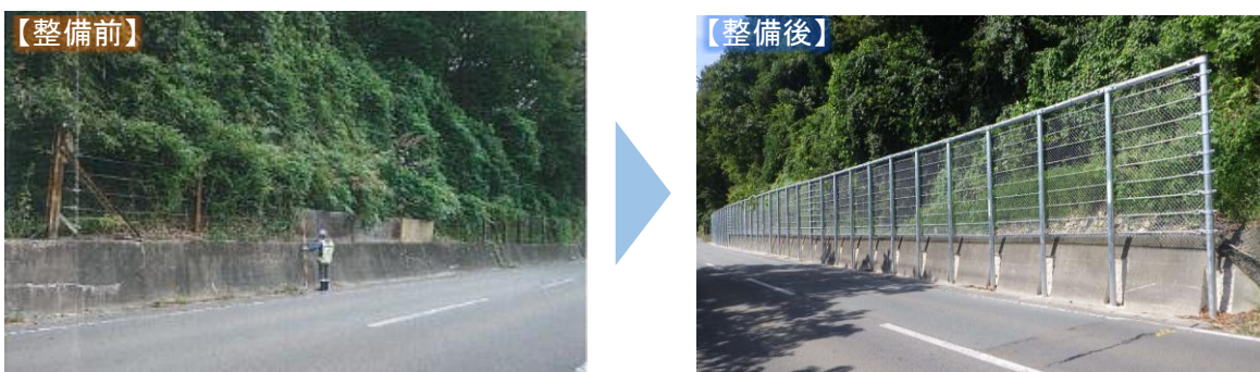
図 3-8 落石防止対策の事例(落石防護柵の設置) (主)天童大江線(大江町左沢楯山)
