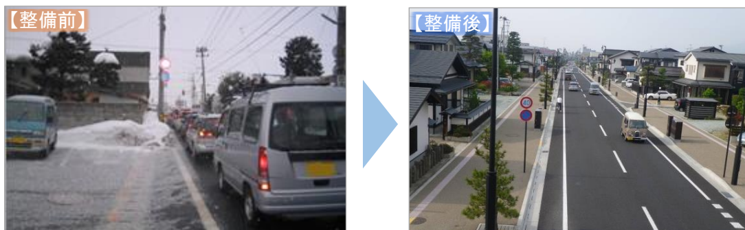
図 1-62 無電柱化の整備事例:(都)山形老野森線(天童市) 出典:山形県資料
