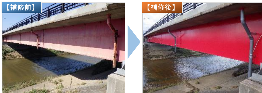
図 40 (主) 余目加茂線 落合橋(庄内町)の橋梁上部工補修事例
