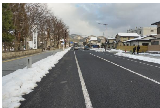
▲十分な幅員の路肩の整備事例 (主)山形山寺線(山形市薬師町)
