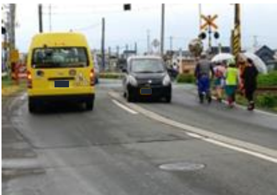
▲(一)泉田新庄線(新庄市太田踏切) 通学路の歩道整備(踏切拡幅)
