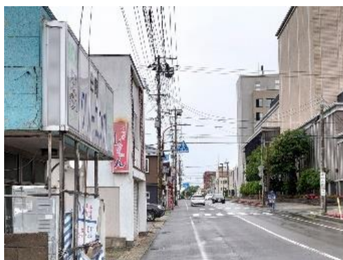
▲(国)112号(酒田市本町) 無電柱化・歩道整備
