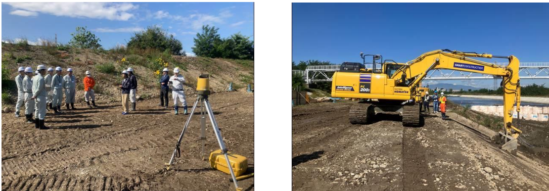
図 4-65 令和5年度に開催されたICT・UAV基礎技術講習会の開催状況（東北土木技術人材育成協議会主催）
