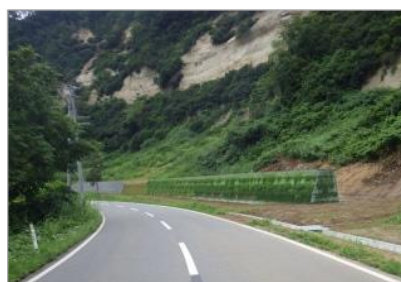
▲ (国) 458 号 (大蔵村南山) 落石防護擁壁
