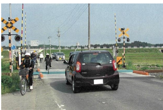
▲(国)458号(新庄市下西山踏切) 通学路の歩道整備(踏切拡幅)
