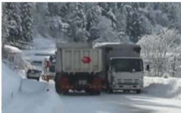
▲(国)287号(朝日町上郷)道路改築
