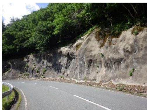
▲(主)山形朝日線(朝日町送橋) 法面对策
