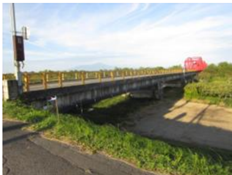
▲(主)庄内空港立川線(三川町) 両田川橋
