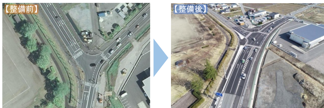
図 3-12 地域の実情に応じた道路改良の事例(交差点改良及び現道拡幅) (国)458号(中山市大字岡～金沢)
