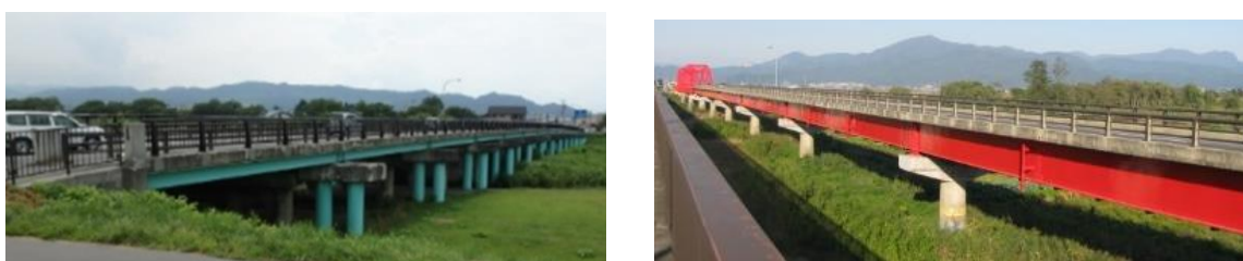
▲(一)板谷米沢停車場線(米沢市) 相生橋架替
