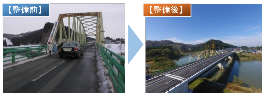
図 36 (主) 大石田畑線 亀井田橋 (大石田町) の橋梁架替事例
