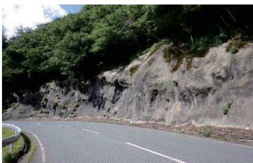
▲(主)山形朝日線(朝日町送橋)法面对策
