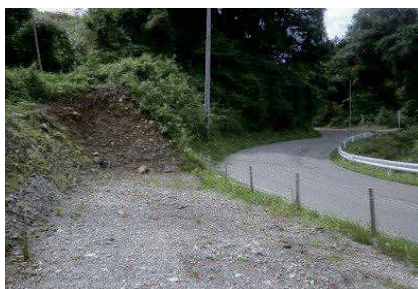
▲地域の実情に応じた道路改良の事例 (主)山形永野線 (山形市土坂)の部分的な拡幅
