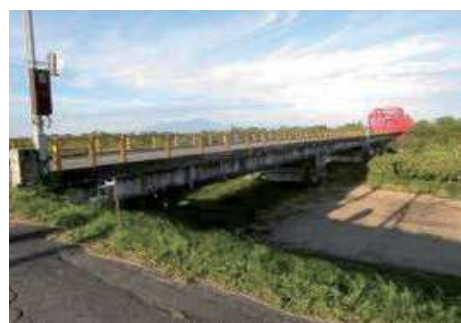
▲(主)庄内空港立川線(三川町)老朽化橋梁架替
