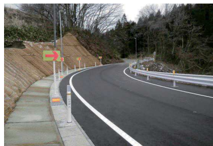
▲地域の実情に応じた道路改良の事例 (主)山形永野線 (山形市土坂)の部分的な拡幅
