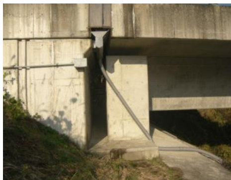
例.後付による非排水化（受樋の設置）
