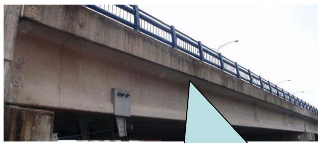
塗装の劣化による桁の腐食
