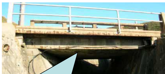
雨水の浸水による支承の腐食
