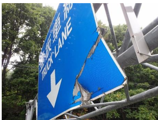
写真 2-5 標識板 変形
