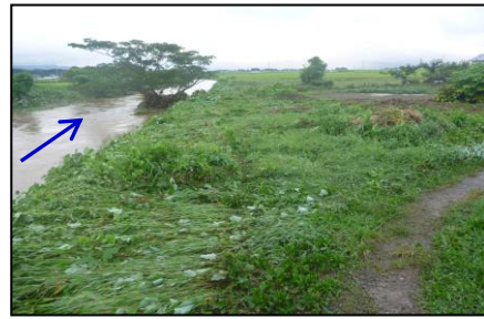
写真 5.1-11 千原橋上流 浸水痕跡 ※草の倒伏状況から溢水を確認
