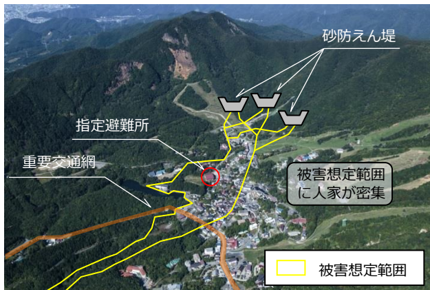
写真 5.2-7 土石流対策事例（砂防事業） 上ノ代沢（山形市）
