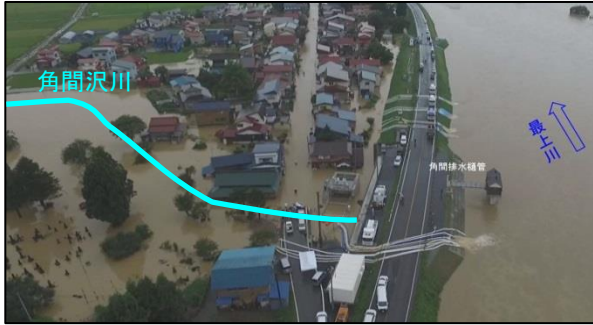
写真 5.1-8 角間沢川 平成30年8月の浸水状況 写真提供：国土交通省 東北地方整備局 新庄河川事務所
