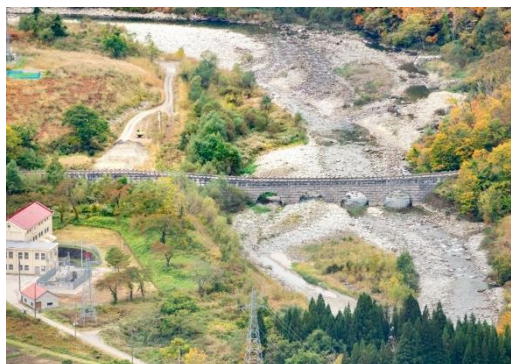
写真 5.2-23 玉川スーパー暗渠砂防えん堤
