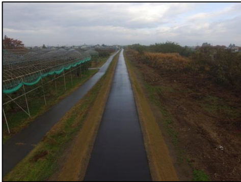
写真 5.1-9 馬見ヶ崎川 堤防天端舗装
