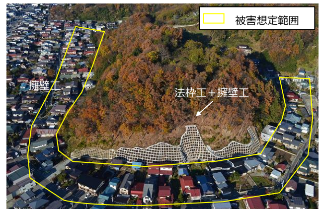
写真 5.2-8 がけ崩れ対策事例（急傾斜事業） 北目(4)（天童市）
