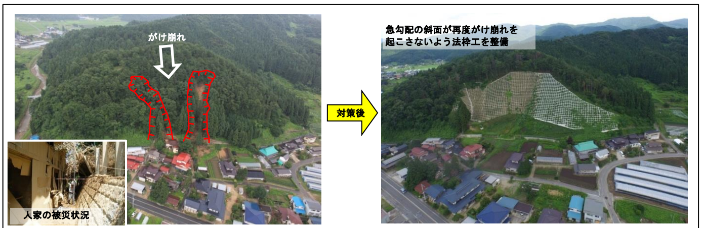
写真 5.2-11 災害発生箇所における対策事例（急傾斜事業） 田辺（白鷹町）
