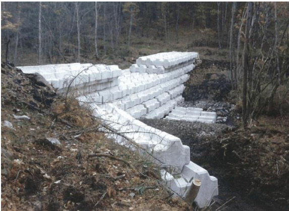
写真 5.2-13 御嶽山の応急対策事例 （仮えん堤）
