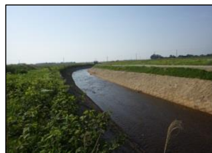
写真 5.1-13 千原橋上流 堆積土砂撤去状況
