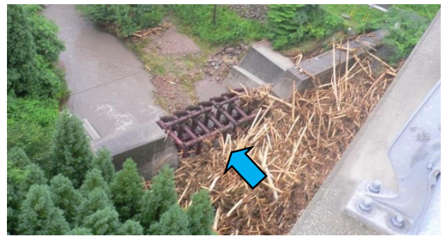
写真 5.2-18 土砂・流木捕捉後の透過型砂防えん堤 (写真提供：熊本県)
