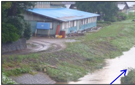
写真 5.1-10 千原橋下流 浸水痕跡 ※草の倒伏状況から溢水を確認
