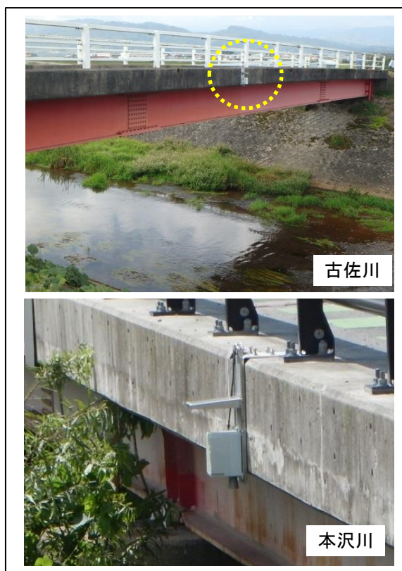
写真 5.1-2 危機管理型水位計の設置状況
