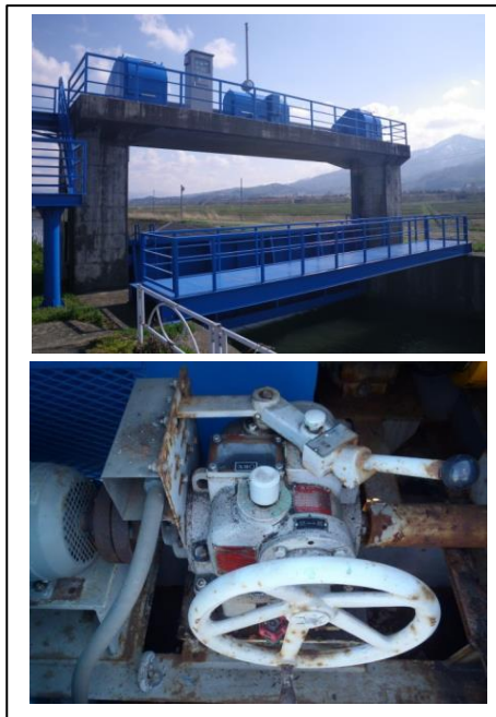
写真 5.1-15 丸岡分水堰（青竜寺川）
