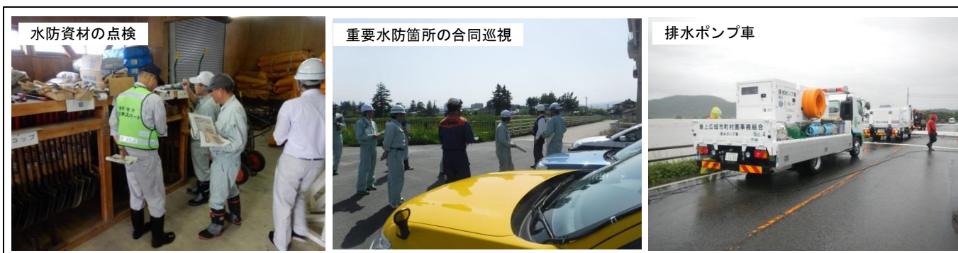
写真5.1-5 水防対応の状況
