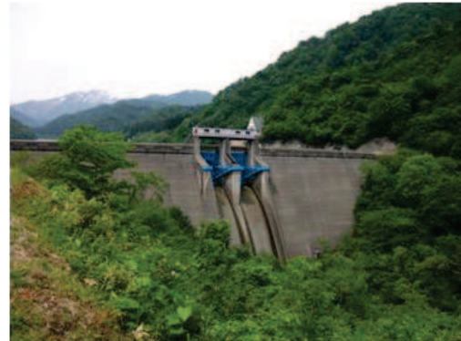
▲右岸駐車帯からダム下流面
