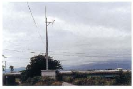
③治水基準点 六田水位観測局舎
