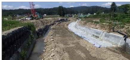
施工状況(萩生川)
