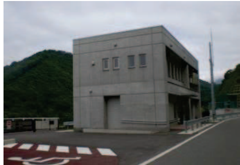
▲ダム管理所外観
