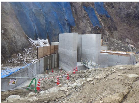
仮排水路トンネル呑口部
