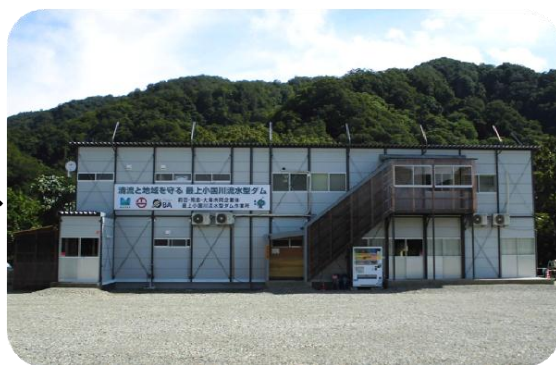
写真: 完成した本事務所
