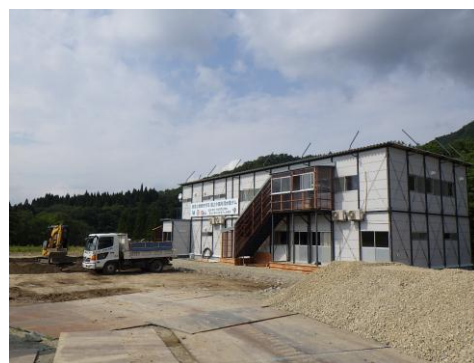
写真： 工事中の現場事務所
