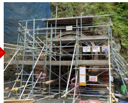
コンクリート工完了(平成27年9月)
