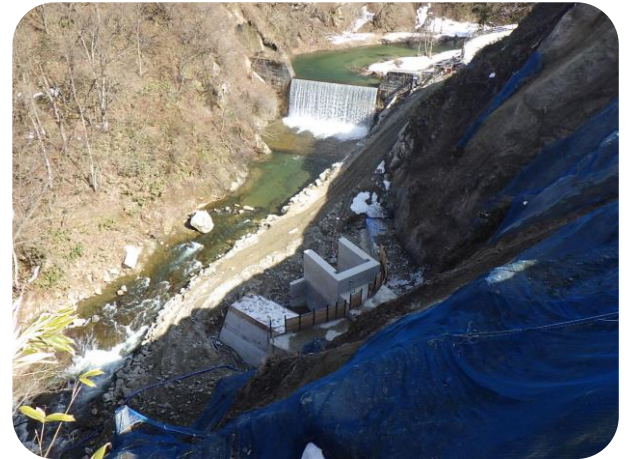
左岸天端より 仮排水路トンネル呑口部を望む
