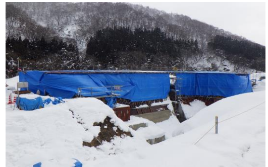
養生状況(外観)
