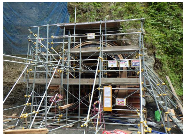
写真：トンネル入口部の施工状況
