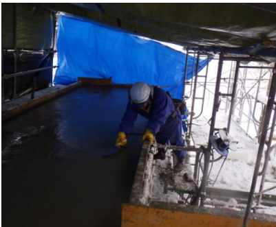
雪を防ぎながらのコンクリート 仕上げ作業の様子
