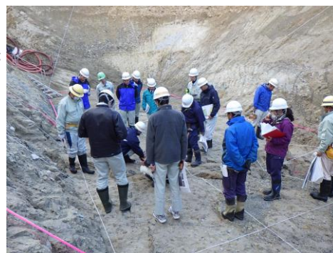
(地盤検査状況)
