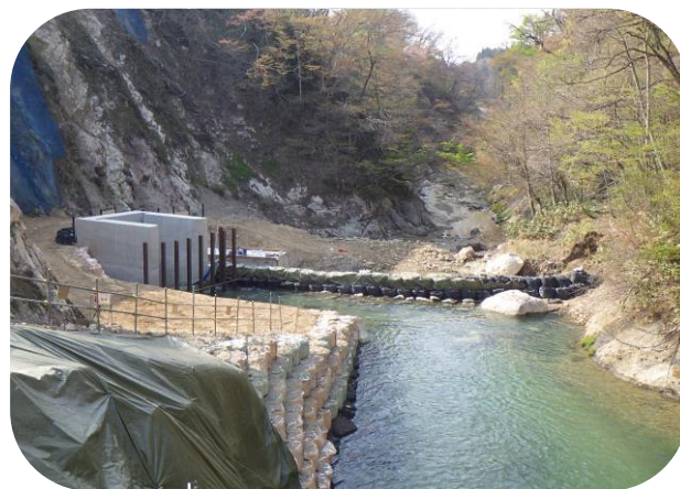
転流した様子(上流側より撮影)
