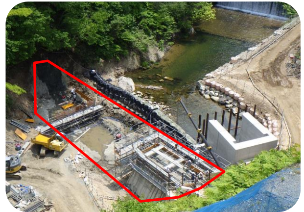
写真：上流二次仮締切を施工中です
