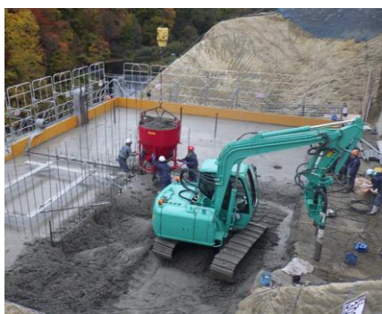
ダム本体打設の様子
