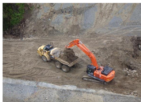
重ダンプトラックによる残土運搬
