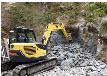
呑口部掘削(平成27年7月)
