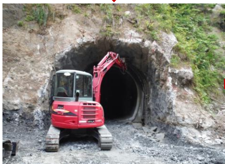
トンネル部掘削(平成27年8月)
