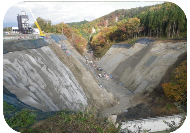
展望台からのダムサイトの様子
