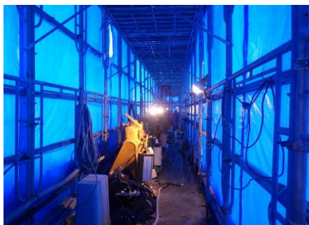
雪囲い中での作業の様子
