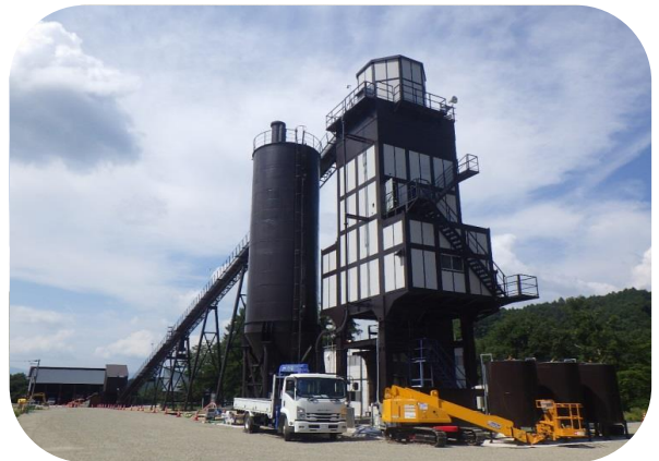
ダム用仮設備全景
