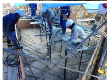
コンクリート打設の状況
