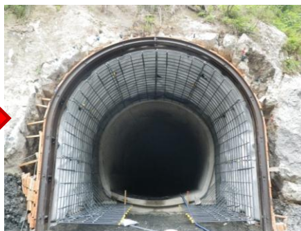
止水・鉄筋工(平成27年8月)
