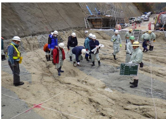
基礎地盤検査の様子(現地確認)
