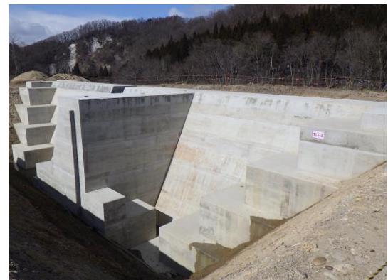
左岸端部処理工
