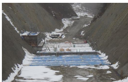
コンクリート養生の準備状況 (堤体河床部)
