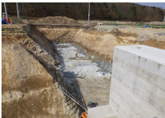
左岸擁壁部掘削完了
