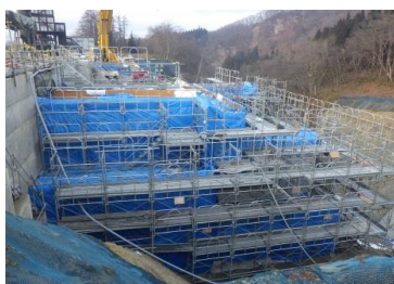
コンクリート養生の準備状況 (堤体左岸側)
