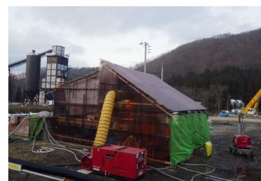
仮設備の雪囲い一例
