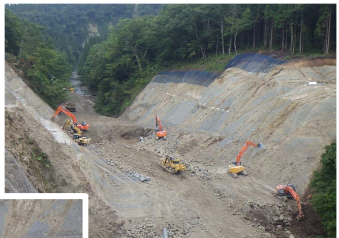
基礎掘削工事状況
