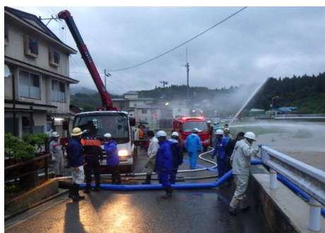
排水作業の様子
