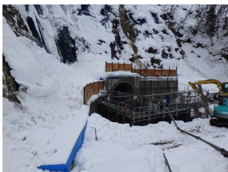
呑口導流壁工
