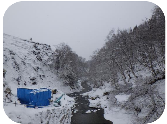
現在の仮排水路トンネル呑口部
