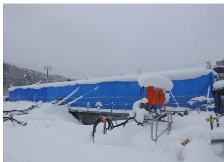
作業箇所の雪囲い
