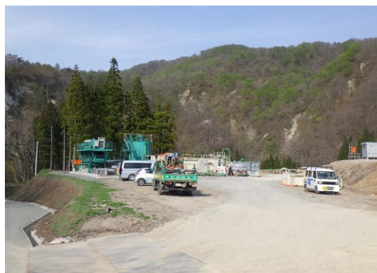
濁水処理設備設置の様子
