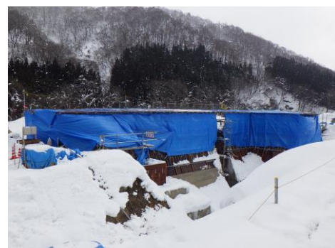
左岸端部処理工
