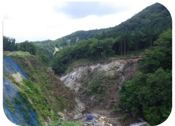
写真：展望台よりダムサイトを望む (堤体部の伐採、掘削作業中です)
