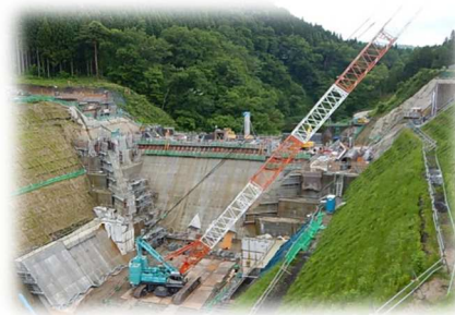
堤体工事の状況
