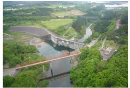
重力式コンクリートとロックフィルの複合構造
