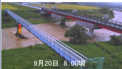
相沢橋水位観測所付近状況
