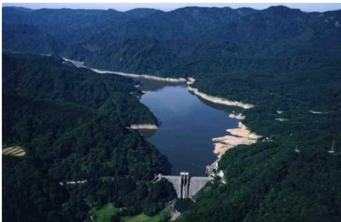
( 荒沢ダム全景 )
