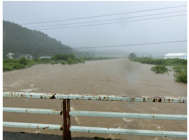
下流河川出水状況
