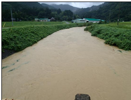
平成30年8月31日 13時00分頃 ダム下流約1km 築場橋付近
