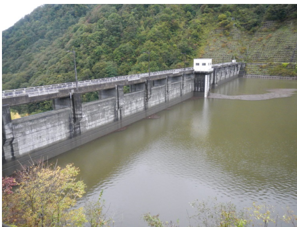
令和 1年10月13日 7時00分頃 神室ダム
