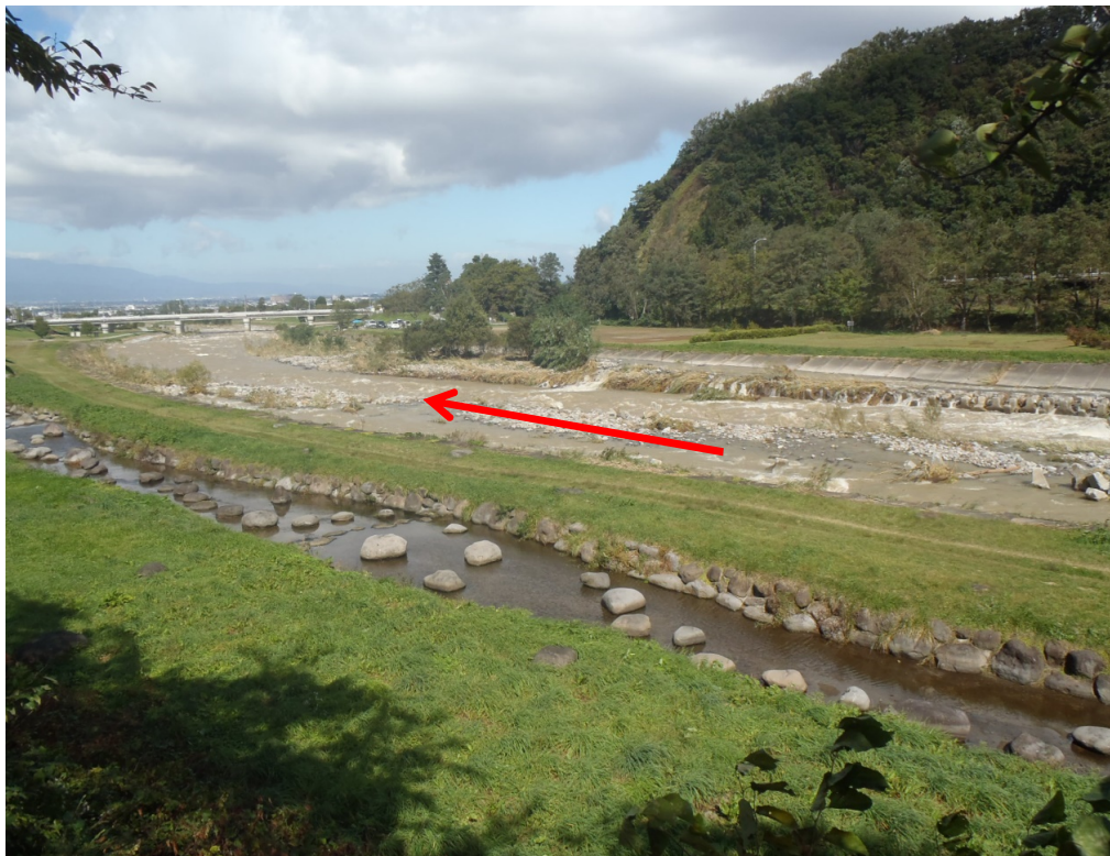
馬見ヶ崎川(山形市内、山形大橋)出水状況 13日 11:00
