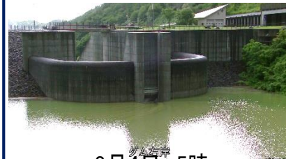
綱木川ダム貯水状況
