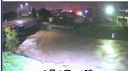
綱木川 館山水位観測所付近の状況
