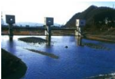
馬見ヶ崎川合口頭首工
