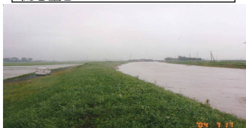
H16.7.17 東北横断自動車道酒田線付近右岸から新井田川上流を望む
