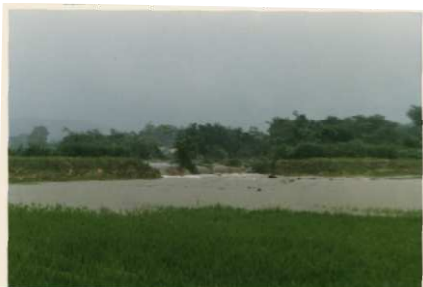
庄内高瀬川の 堤防決壊箇所
