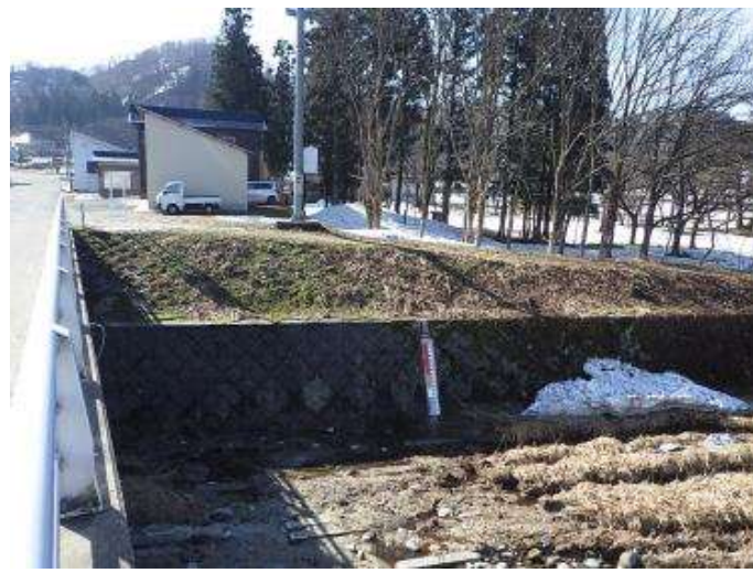
見やすい量水標の設置(荒川(小国町五味沢))H30設置
