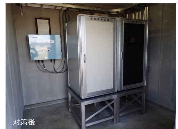
▲ 対策例（六田水位観測所） 観測機器を設定水位以上に再配置
