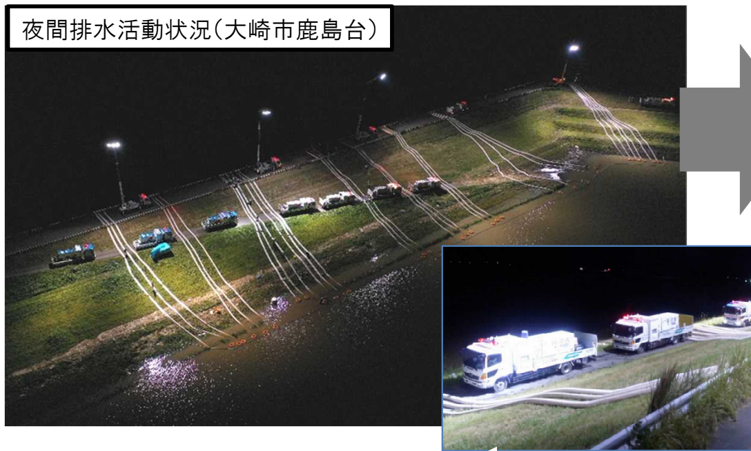
排水活動状況(大崎市鹿島台)
