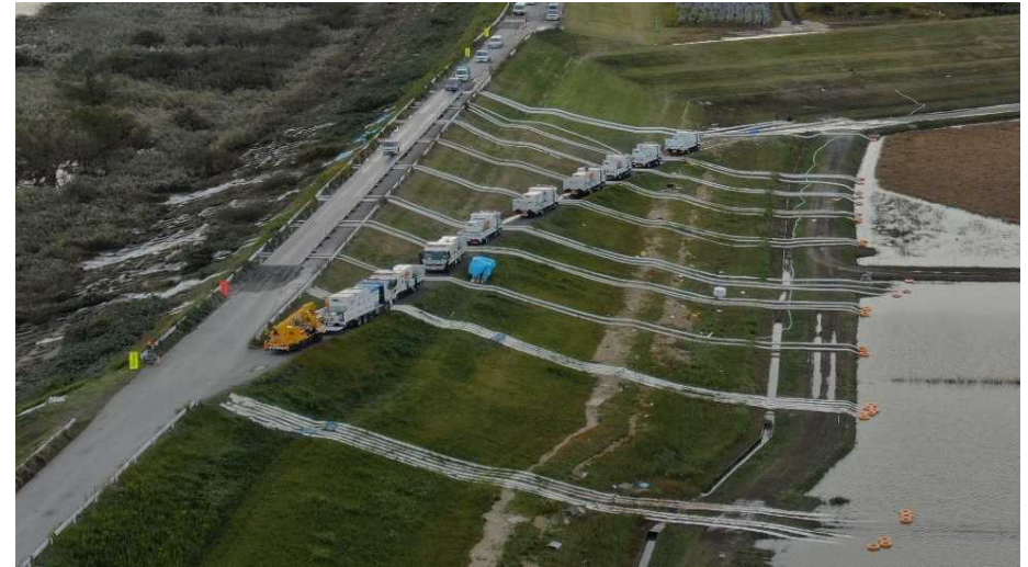
吉田川における排水作業状況
