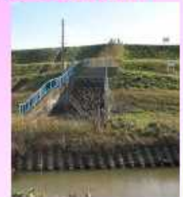
内浦緊急排水樋門（呑口部）
