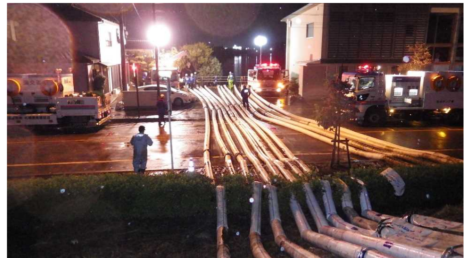
郡山市内の浸水箇所における排水作業状況
