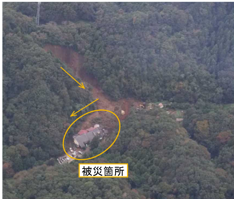
崩壊箇所全景
