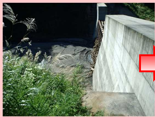
西尾野川第3号堰堤 (H27.10.31) 糸魚川市大平 東日本台風に伴う流出土砂等の捕捉状況
