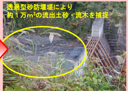
西尾野川第3号堰堤 (H27.10.31) 糸魚川市大平 東日本台風に伴う流出土砂等の捕捉状況
