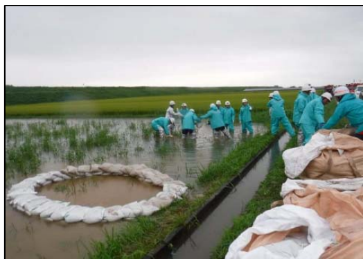
最上川での水防活動(釜段工)
