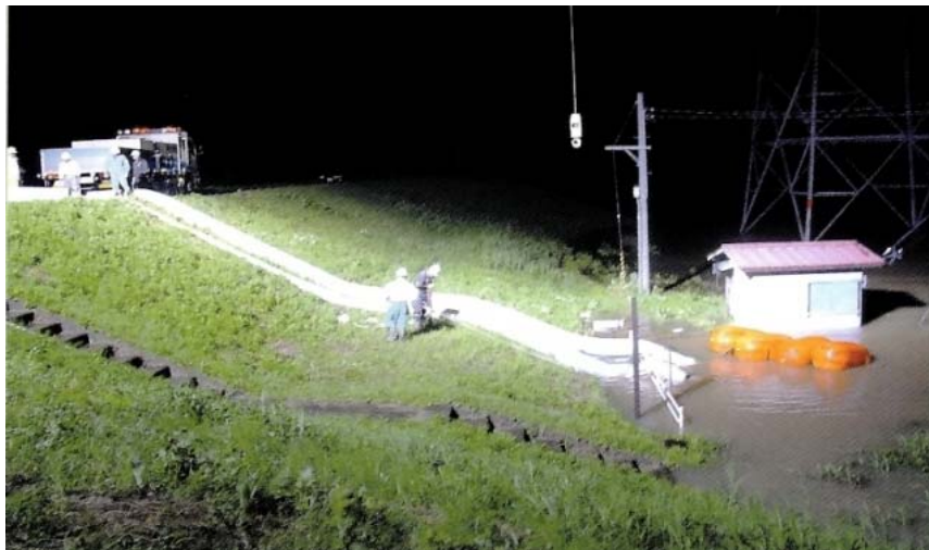
排水ポンプ車による内水排除状況
